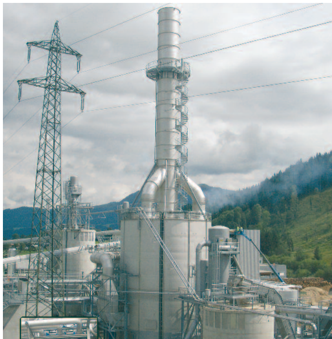
Mit einem Nasskohleelektrofilter können Feinstäube u. ä. abgetrennt werden.
